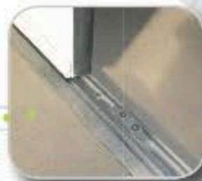
Profil jet d'eau en partie basse de la porte, complémentaire de notre seuil en aluminium anodisé
