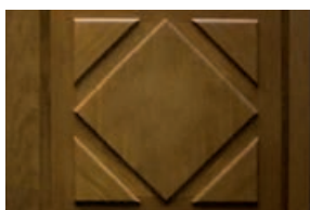
panneau à table saillante en losange
