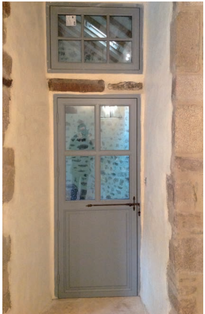
Edwige en situation avec petits bois mortaisés et adaptation d'une fermeture à loquet de récupération
