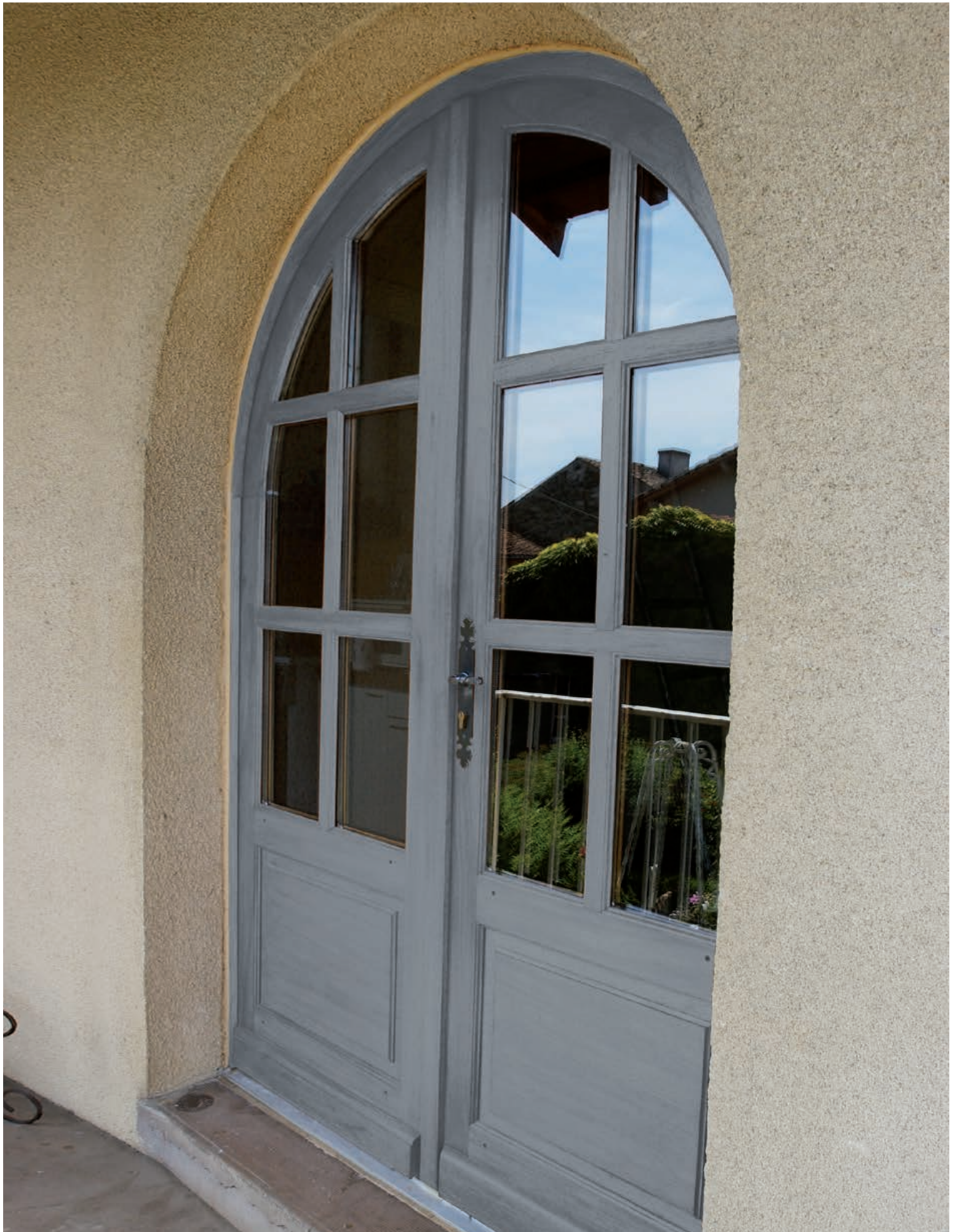
Edwige en situation réalisée cintrée en 2 vantaux avec petits bois mortaisés
