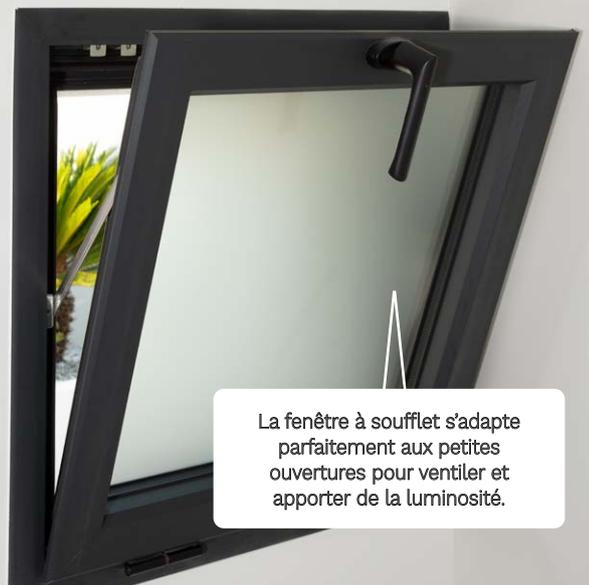
La fenêtre à soufflet s'adapte parfaitement aux petites ouvertures pour ventiler et apporter de la luminosité.
